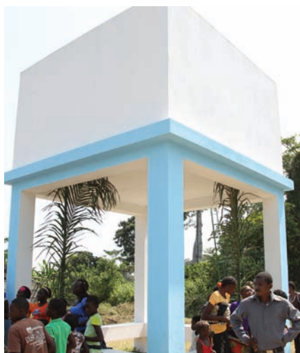
Tanque de água de apoio ao centro de saúde de Mandarim.
