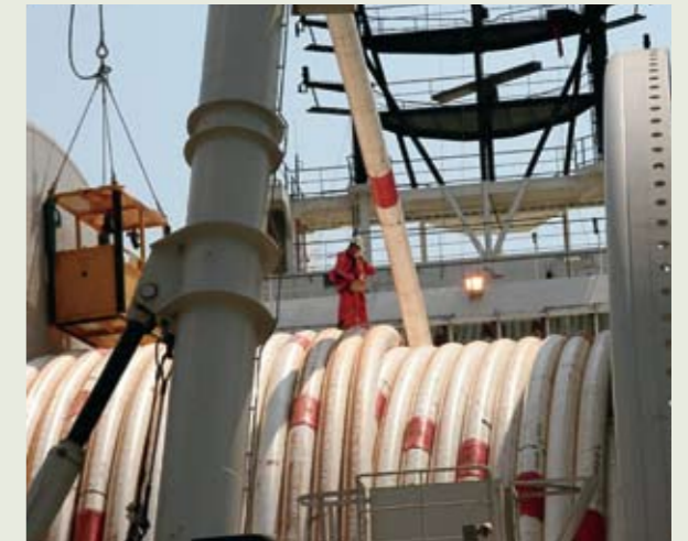
Tubo subaquático encanelado e instalado
