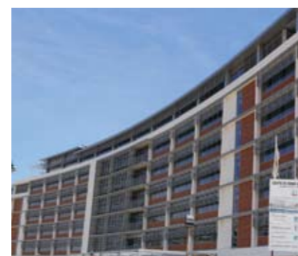
Edifício Chicala em Luanda, nova sede da CABGOC
